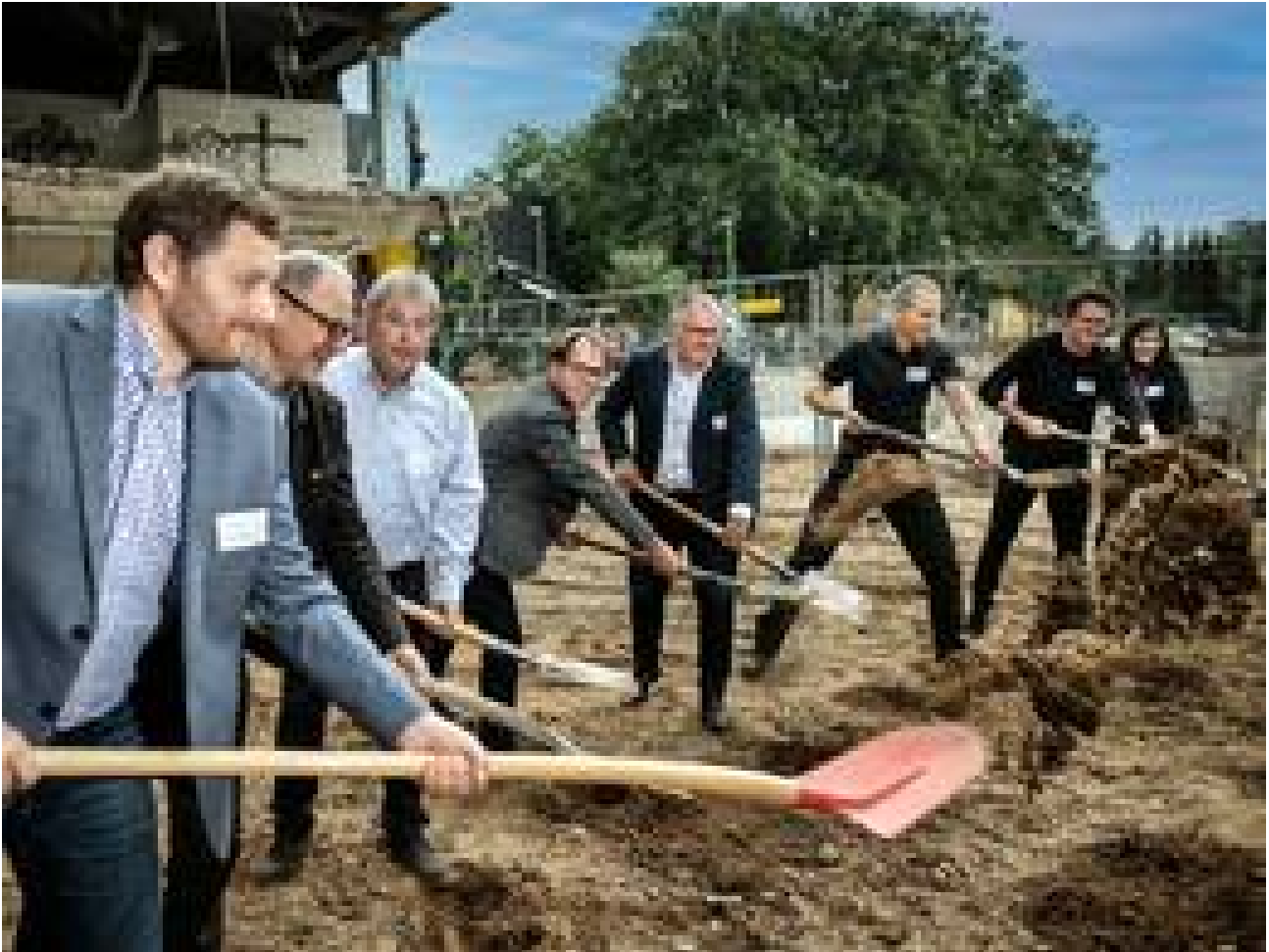
Leichlingens Bürgermeister Frank Steffes (m.) mit Vertretern der Investoren beim symbolischen ersten Spatenstich. →Foto: rm- Foto: Matzerath, Ralph (rm)/Matzerath, Ralph (rm-)
