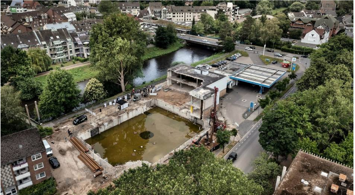
Das Baugelände grenzt ans Wupperufer. Die alten Gebäude sind größtenteils abgerissen. Foto: Matzerath, Ralph (rm)/Matzerath, Ralph (rm-)
